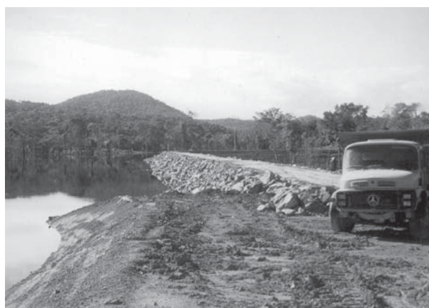
Figura 4. Um dos segmentos da hidrelétrica de Jatapu.
