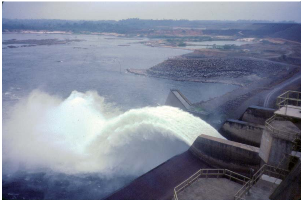
Figura 2. Vertedouro em Tucuruí. O desenho em forma de salto de esqui oxigena a água, mas, ao mesmo tempo, libera o metano imediatamente. O vertedouro tira água de uma profundidade de 20 m, onde a concentração de metano é alta (Fearnside, 2001).
